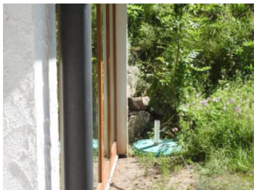
Abbildung 3: Kleine Stützmauer randlich des Pavillon
