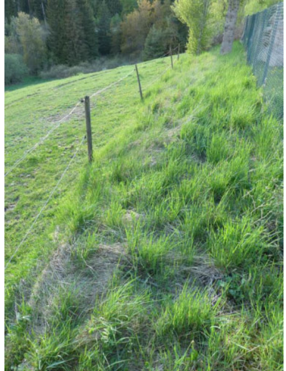
Abbildung 15: Standort der geplanten Trockenmauer entlang des Viehzauns
