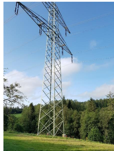
Abbildung 19: Strommast südöstlich des Plangebiets (Foto: Kunz GaLaPlan)
