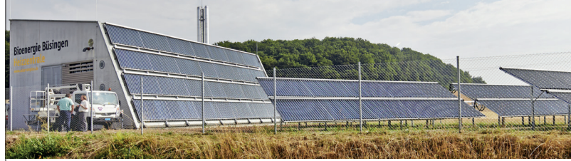
Gutes Beispiel: In Bisingen am Hochrhein speisen eine Holzhackschnittelheizung sowie eine solarthermische Freilandanlage in ein Wärmenetz ein. Bildquelle: Solarcomplex AG
